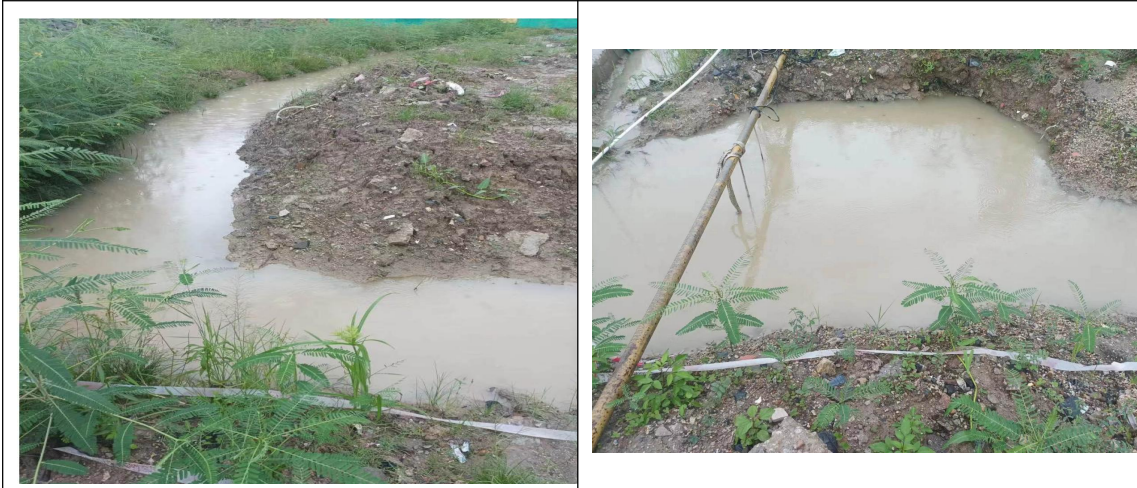
场内水做排水沟和集水池，沉淀过滤后循环使用，用于现场工地临时用水
