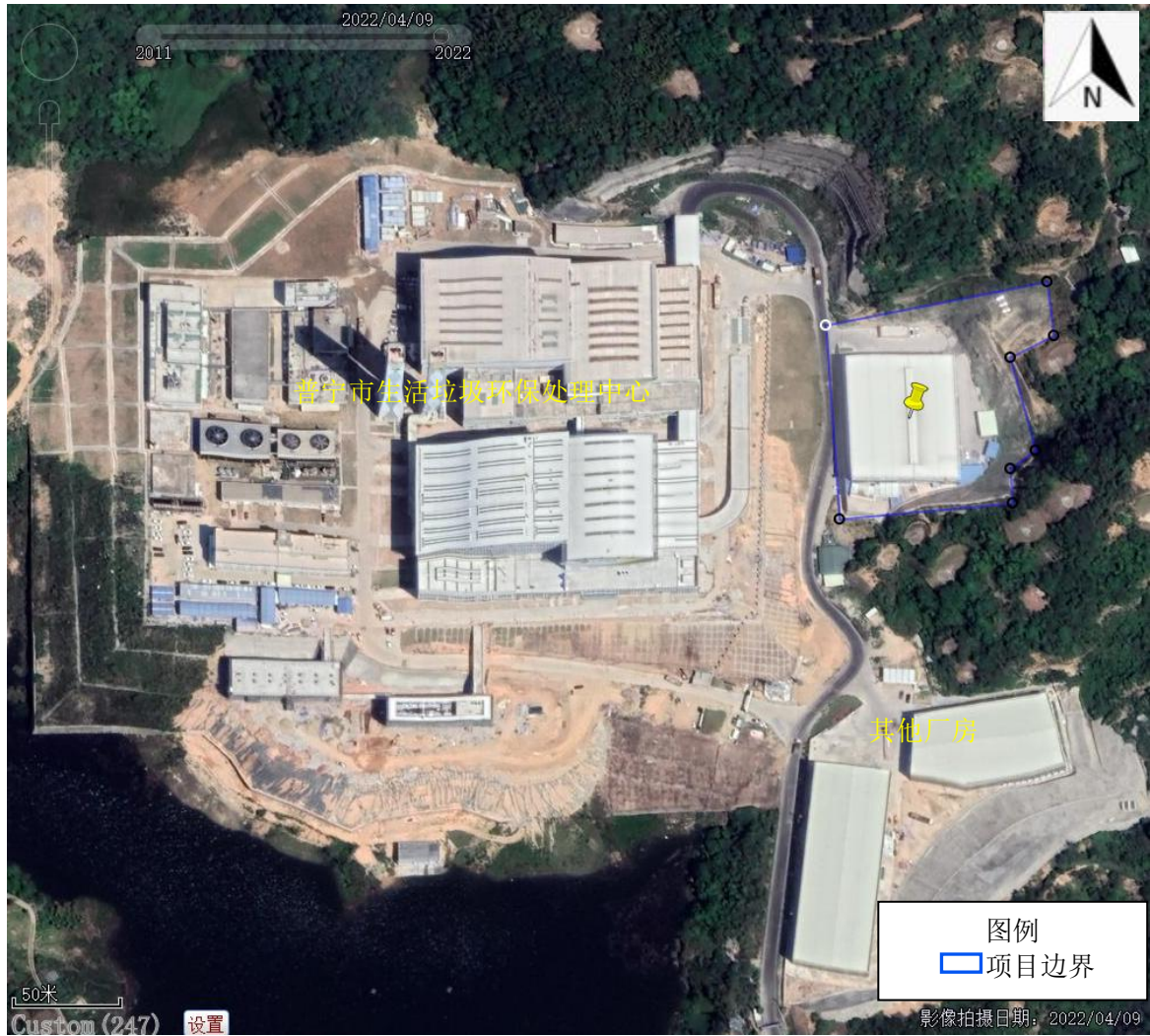
图2.5-2 普宁市美佳兰城建材有限公司周边现状情况
