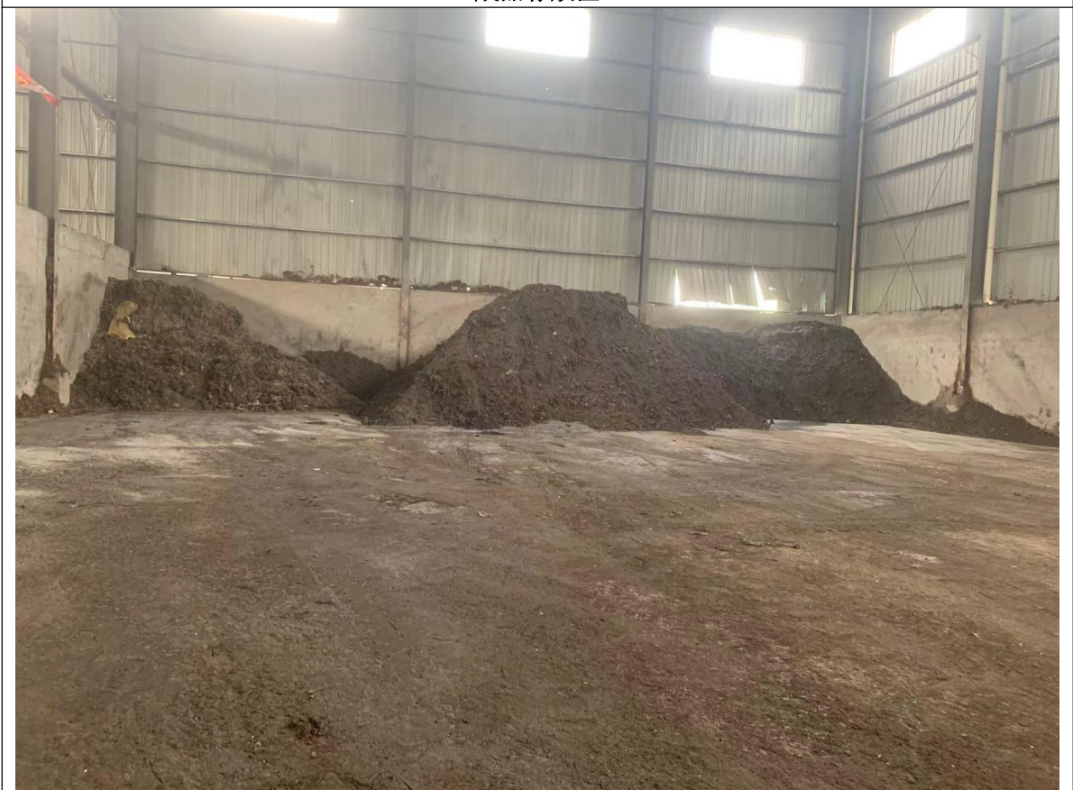
炉渣集料堆放区
